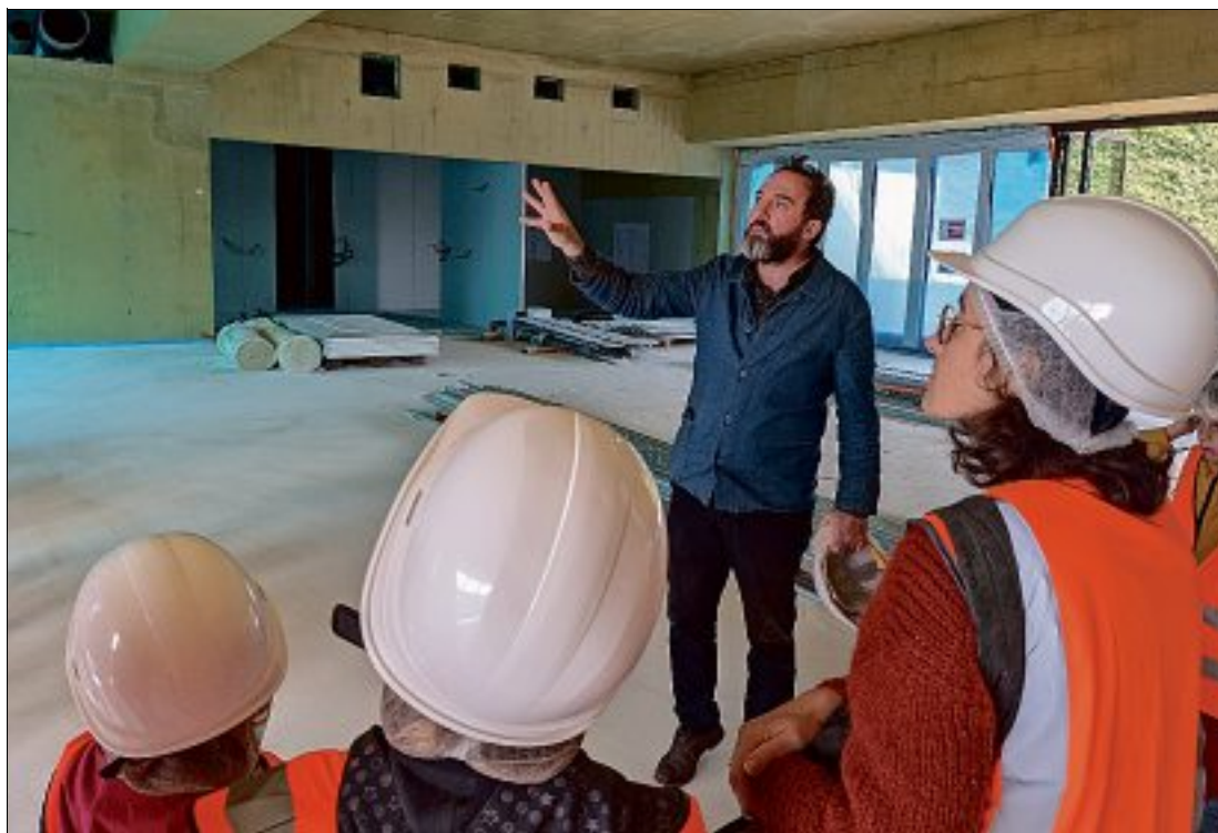
TRAVAUX. Ce chantier du centre de loisirs, comprenant la restructuration de la restauration, s'élève à 8 millions d'euros.
